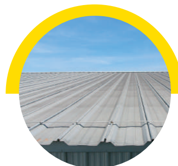
Telhados com alta exposição ao sol
